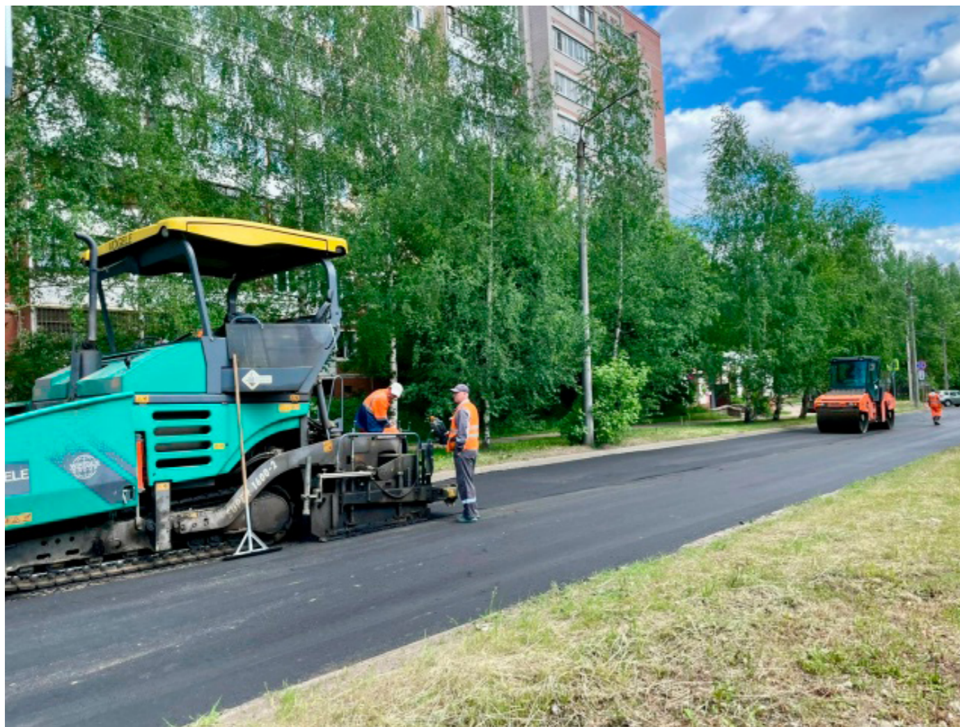
■ Выполнены работы по асфальтированию межквартирных проездов по улице Южной в районе дома №11
